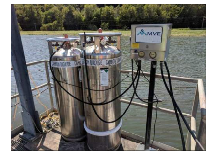
MVE CO2 DELIVERY BOX (3 S-201) N.T.S.
