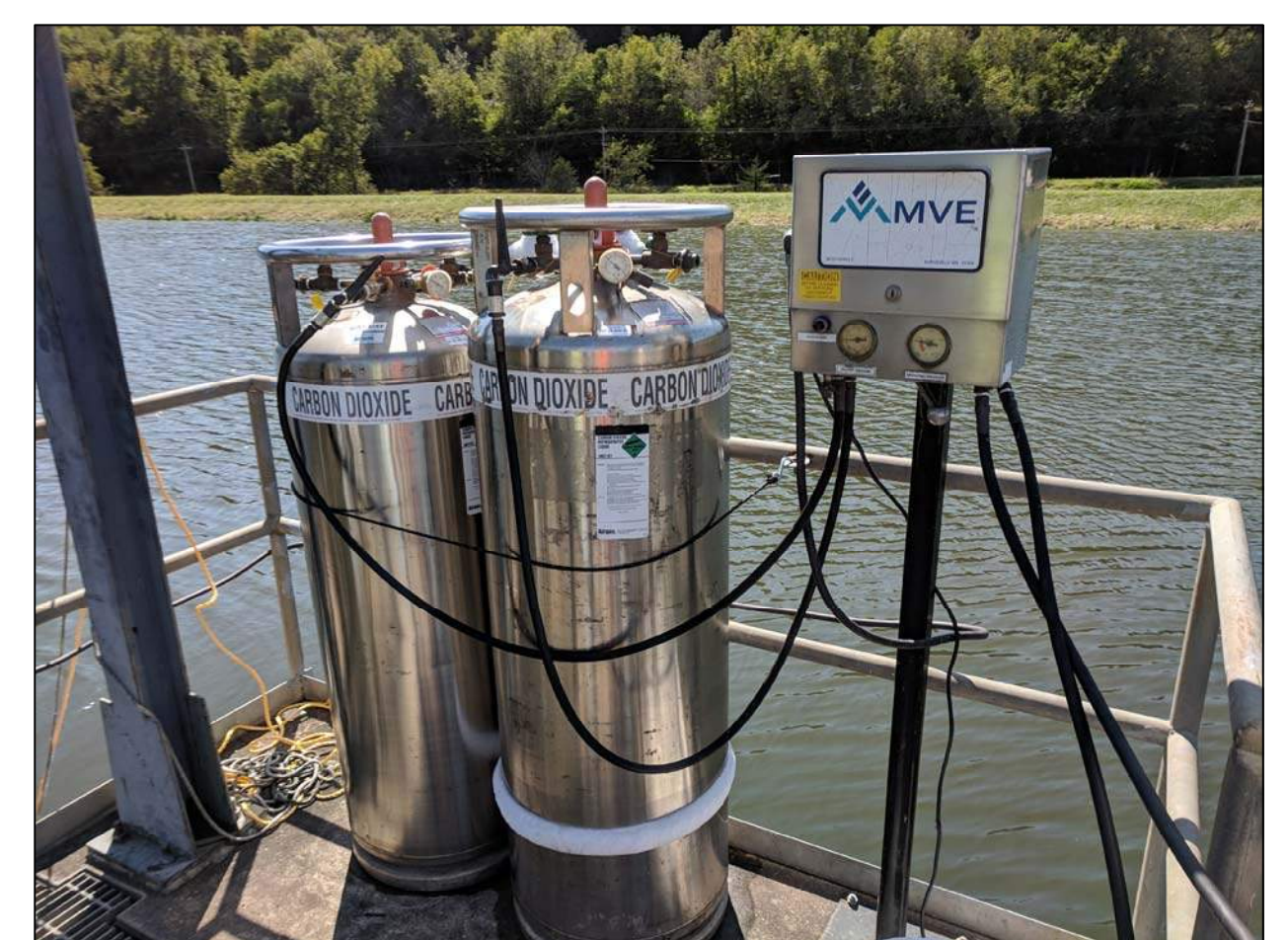
MVE CO2 DELIVERY BOX (3 S-201) N.T.S.
